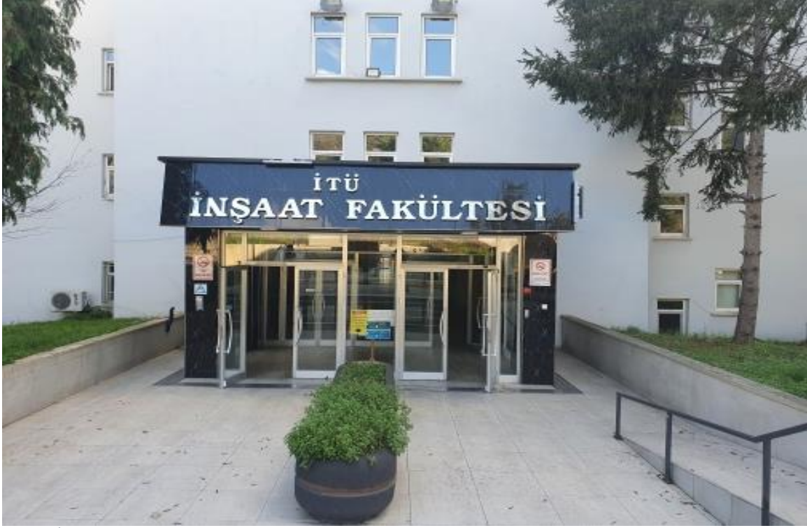
Şekil 5. İnşaat Fakültesi Girişi
