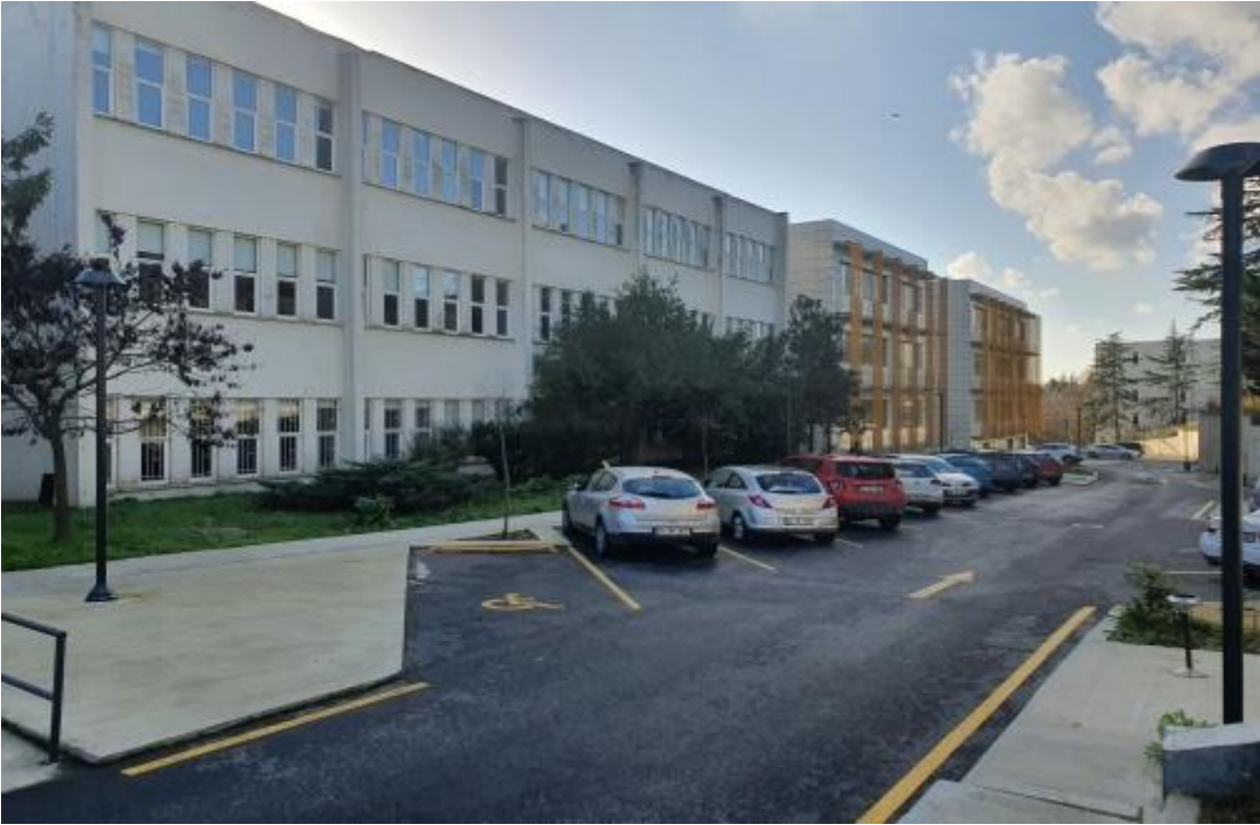
Şekil 6. İnşaat Fakültesi Otoparkı
