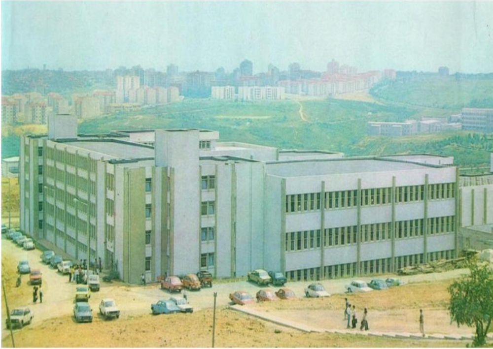
Şekil 4 : İTÜ İnşaat Fakültesi
